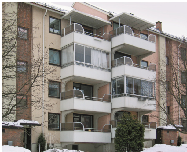
Fig. 74 a Eksempler på påhengte balkonger med innglassing. At noen balkonger er glasset inn og andre ikke, gir fasaden et variert uttrykk. Foto: SINTEF Byggforsk
