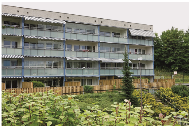
Fig. 72 Nytt brystningssystem tilrettelagt for innglassing av balkongen. Foto: Balkongforeningen i Norden
