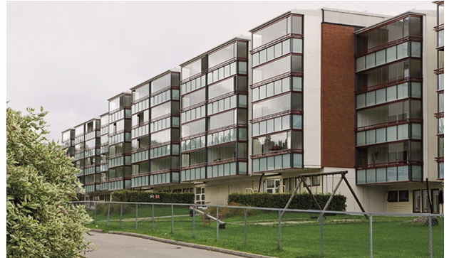
Balkongene på 1960-tallsbebyggelse er skiftet ut og supplert med innglassingssystem for hele fasaden. Den enkle fasaden er blitt svært forandret. Foto: Balkongforeningen i Norden
