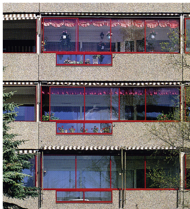
Fig. 71 Skyveglass montert på eksisterende brystning. Foto: SINTEF Byggeforsk
