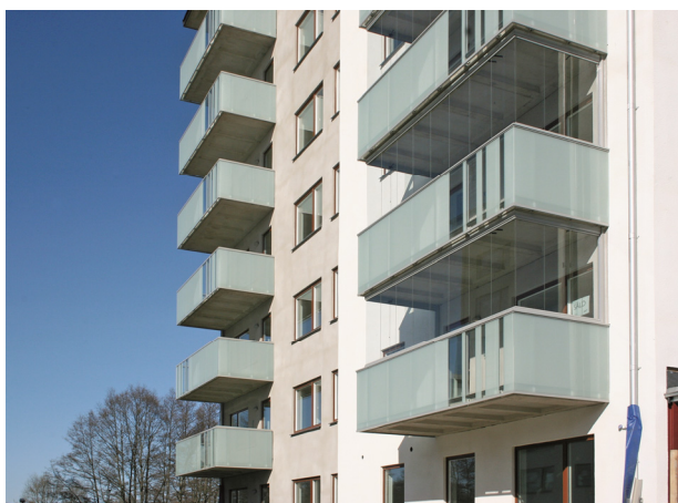
Fig. 74 b Eksempel på påhengte balkonger med lett innglassing hvor glassrutene er uten profiler. Foto: SINTEF Byggforsk
